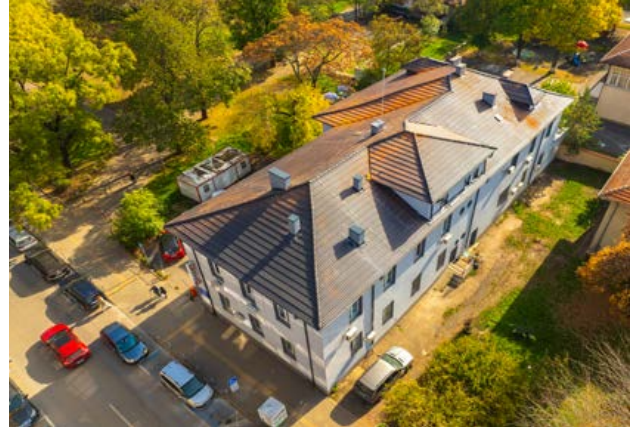
Ремонтиран покрив 11 ДКЦ
