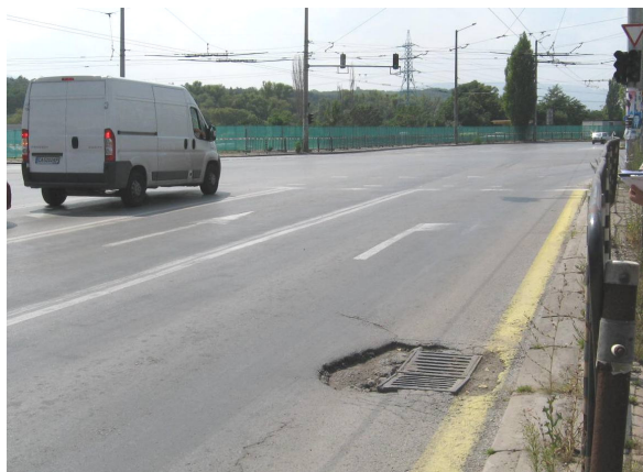
Фигура 5.3: Пропаднала шахта – кръстовище „бул. Царица Йоанна – бул. Добринова скала”
