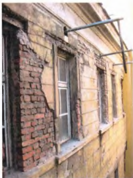
Фотоси 11 и 12. Разрушени мазилки по северната фасада на прохода между източното и западното крило (вляво) и дълбока ерозия на тухлите на стената по ос 4 в северния вътрешен двор с разтителност (вдясно)
