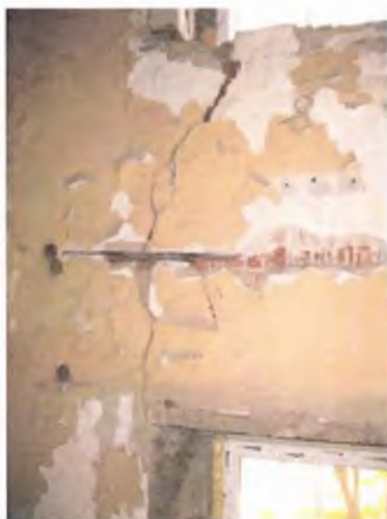
Фотоси 13 и 14. . Магистрални пукнатини по цялата дебелина на стените на стълбищната клетка при северната фасада: на фасадния зид по ос 1 вътре (вляво) и същата пукнатина в ъгъла отвън (вдясно)
