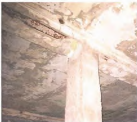
Фотоси 9 и 10. Стоманената колонна в поле 15-16/В-Е на 2 етаж (вляво) и фрагмент от основата с дълбока люспеста корозия (вдясно)
