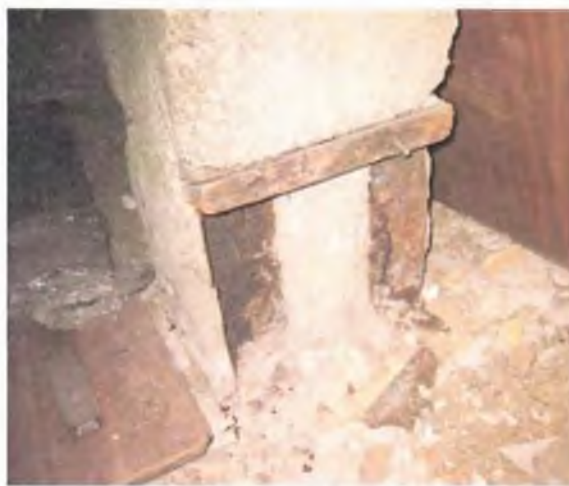
Фотоси 9 и 10. Стоманената колонна в поле 15-16/В-Е на 2 етаж (вляво) и фрагмент от основата с дълбока люспеста корозия (вдясно)
