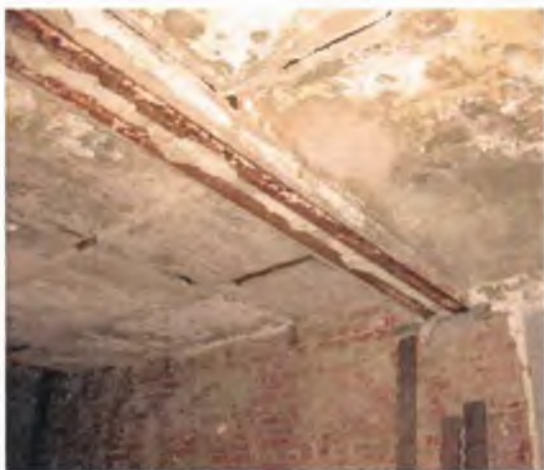
Фотоси 1 и 2. Фрагмент от поле 15-16/В-Е над 2 етаж (вляво) и от провисналото поле 1-15/Е-И, което е с отвор около 5,0м (вдясно)
