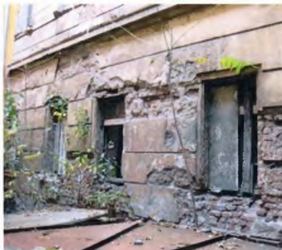
Фотоси 11 и 12. Разрушени мазилки по северната фасада на прохода между източното и западното крило (вляво) и дълбока ерозия на тухлите на стената по ос 4 в северния вътрешен двор с разтителност (вдясно)
