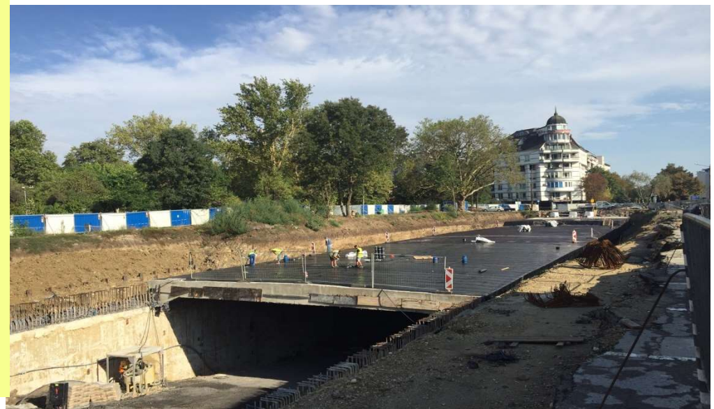
Схема на конструкцията и изглед при строителството по „Милански метод“
