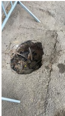
1.9. Обезопасяване при пропадане на пътното платно на ул. „Симеонов век“.
