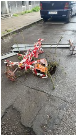
1.9. Обезопасяване при пропадане на пътното платно на ул. „Симеонов век“.
